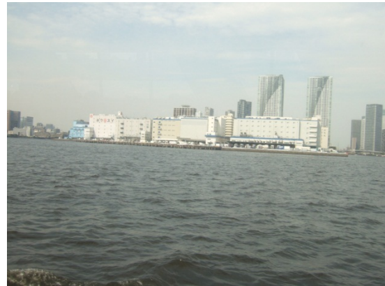
豊海ふ頭の冷蔵倉庫群を海側から確認。
