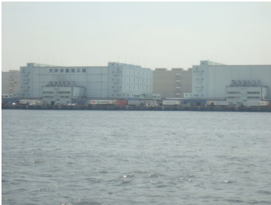
大井水産物ふ頭を海側から確認。
